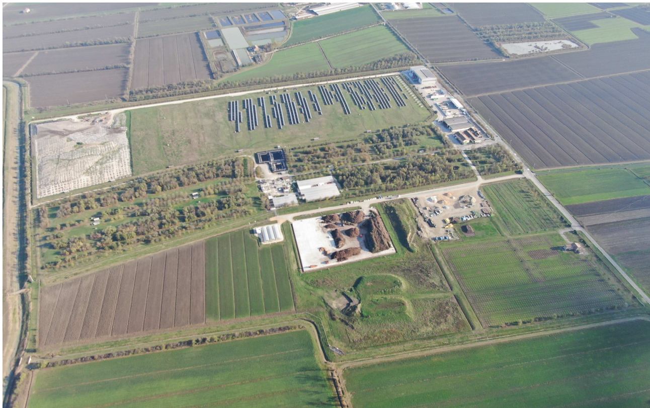
Figura 3 - Vista aerea del sito impiantistico di S.A.BA.R.
