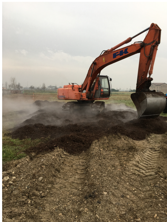
Figura 21: Formazione del primo strato del cumulo.
